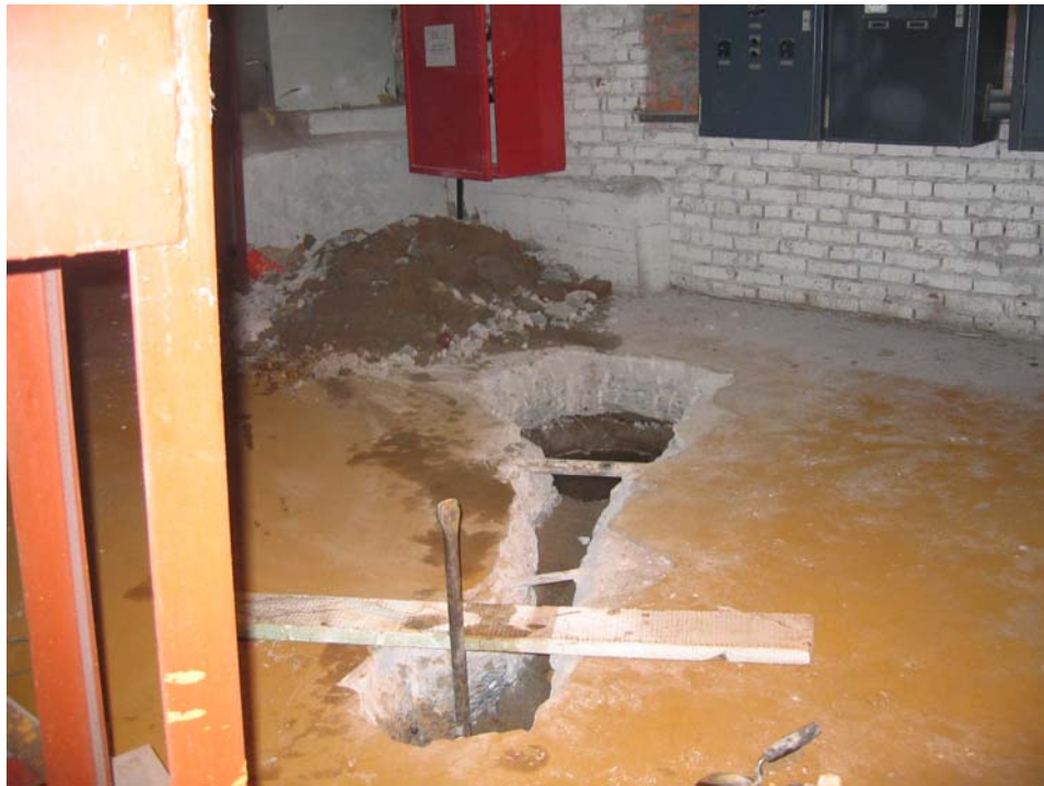
Фото 7. Общий вид места проходки шурфа № 1 ( положение доски и лома обозначают наружную грань фундаментной ленты ).
