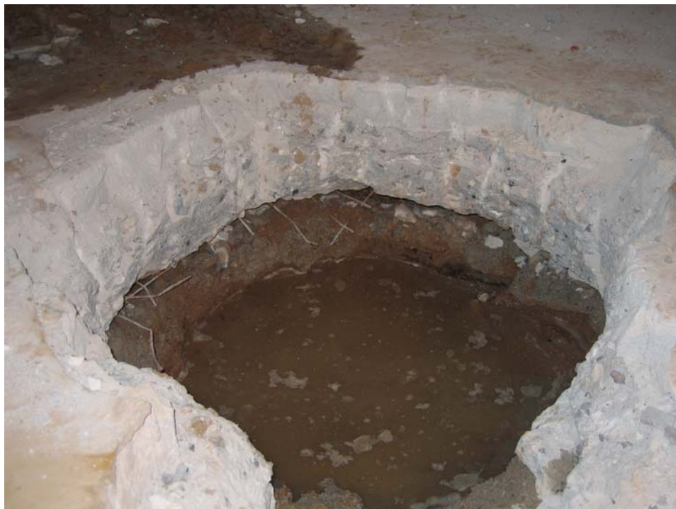
Фото 8. Конструкция пола в шурфе № 1. Уровень воды h = 0,45 м.
