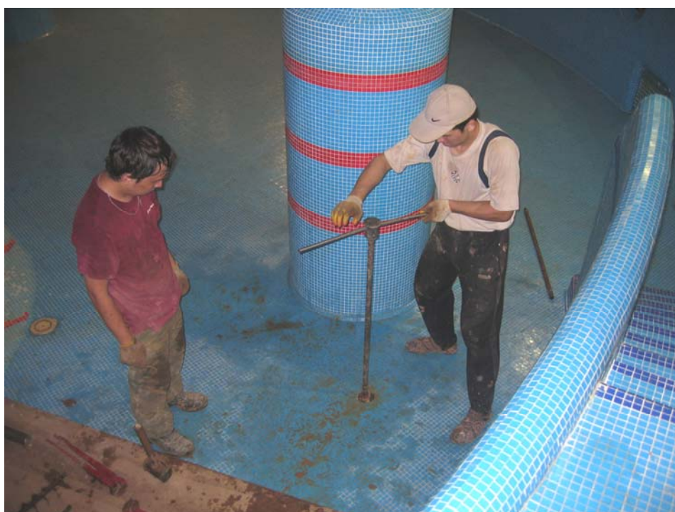
Фото 14. Бурение скважины С-7 вручную с уровня дна бассейна.
