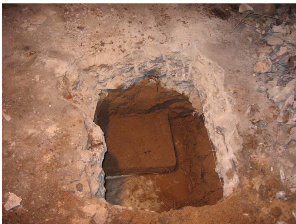
Фото 12. Вид подколонтник из монолитного бетона в шурфе № 4.
